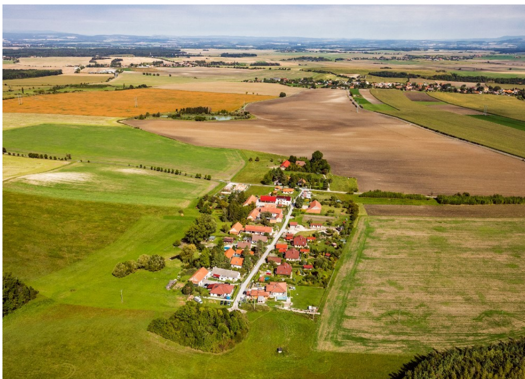
Letecký snímek – místní část Dolní Černilov
